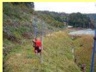
【電気柵の設置】
